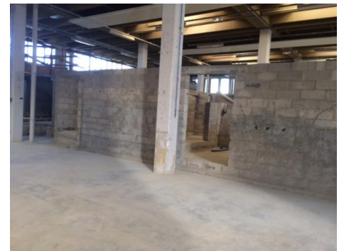
Construction éphémère à l'atelier Gros Œuvre
